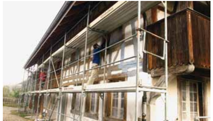
Gemeinsame Fassadenrenovation während der Bauwoche
