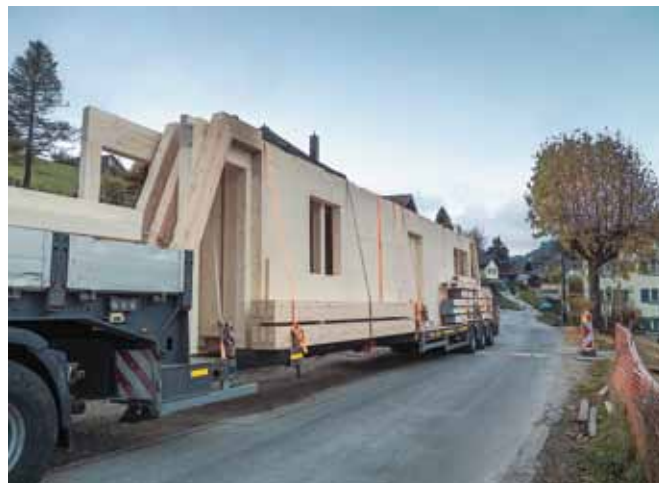
Das Haus wird in seinen Bestandteilen angeliefert.
