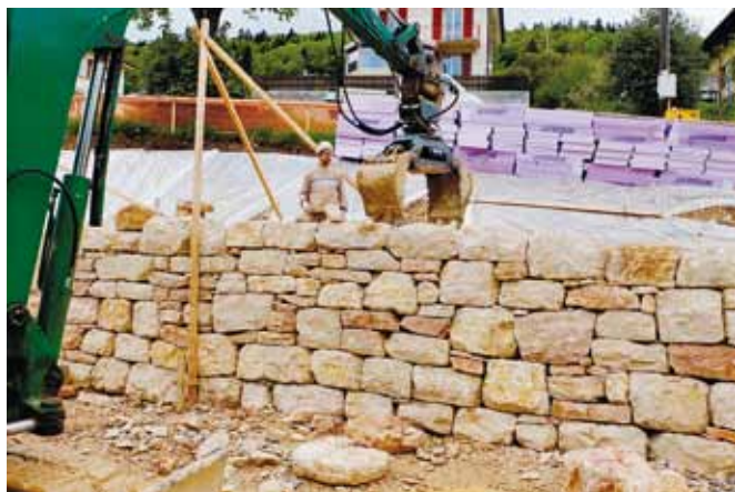
Ein Teilstück der Trockenmauer: schön und unschlagbar im niedrigen Verbrauch an grauer Energie und in seiner Wiederverwertbarkeit
